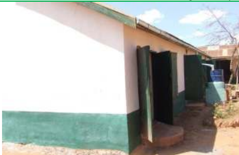
9- Réhabilitation des travaux de peinture d'une salle de classe EPP Bongatsara.
