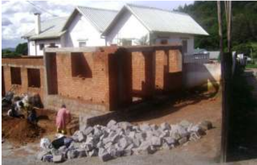
Commencement travaux EPP Ambohibao.
