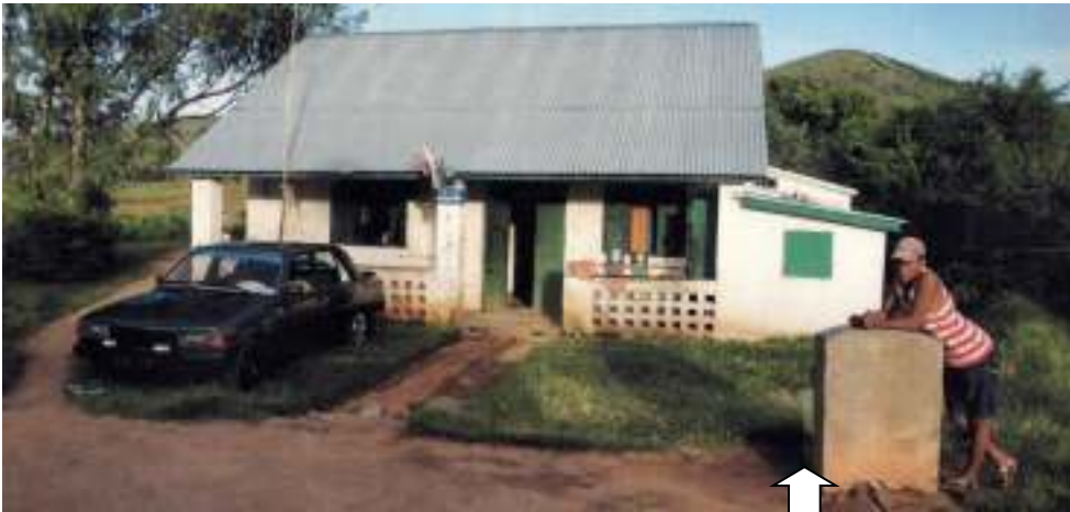
Poste fixe avant
